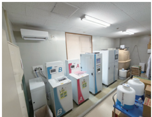
機械室設置完了
