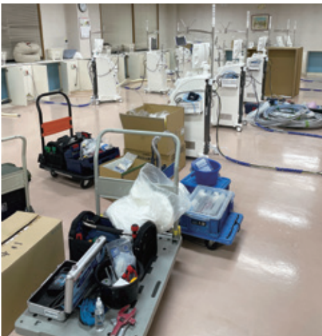
装置接続工事
