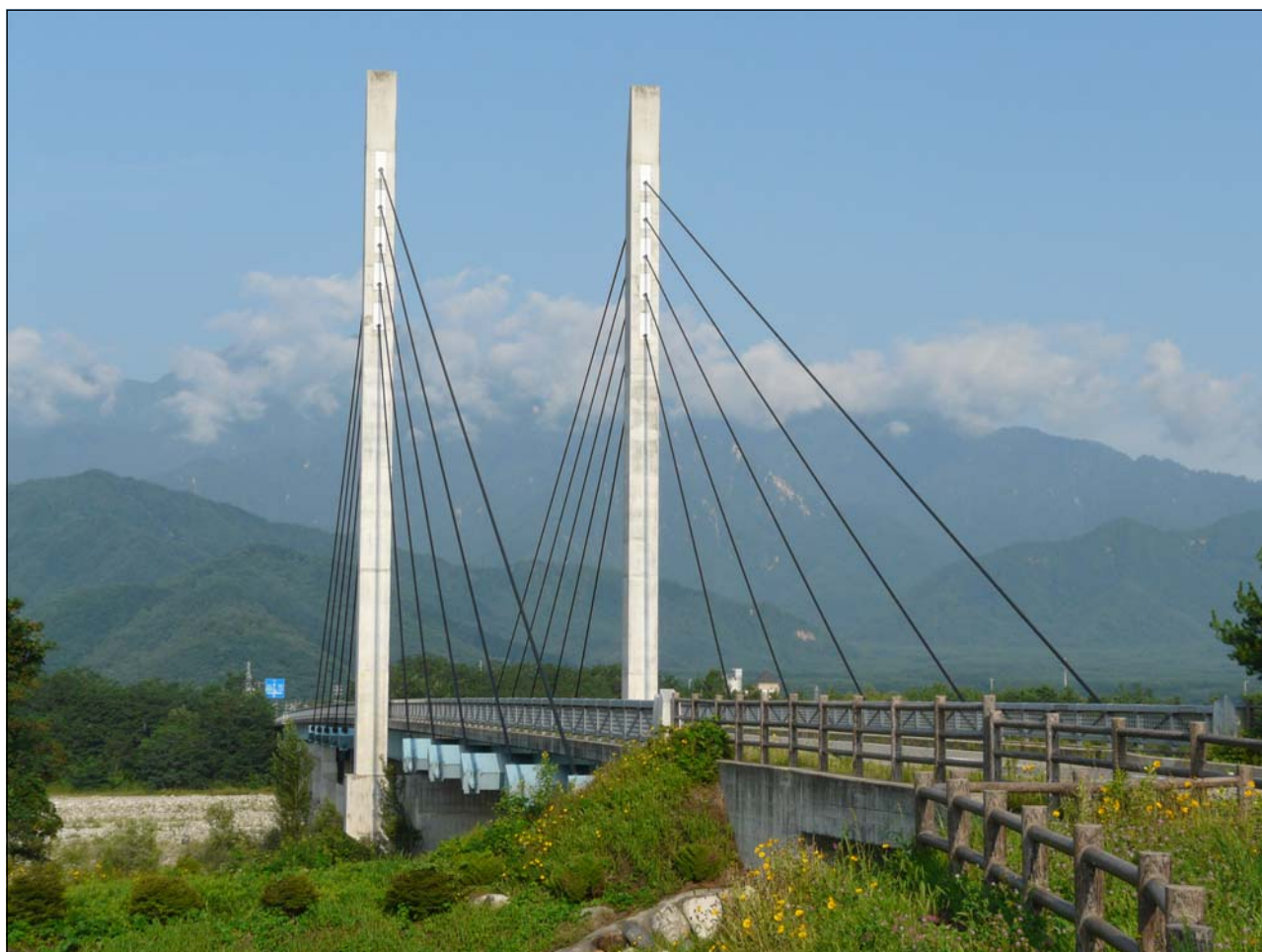
【高瀬川宮本橋（大町市）】
