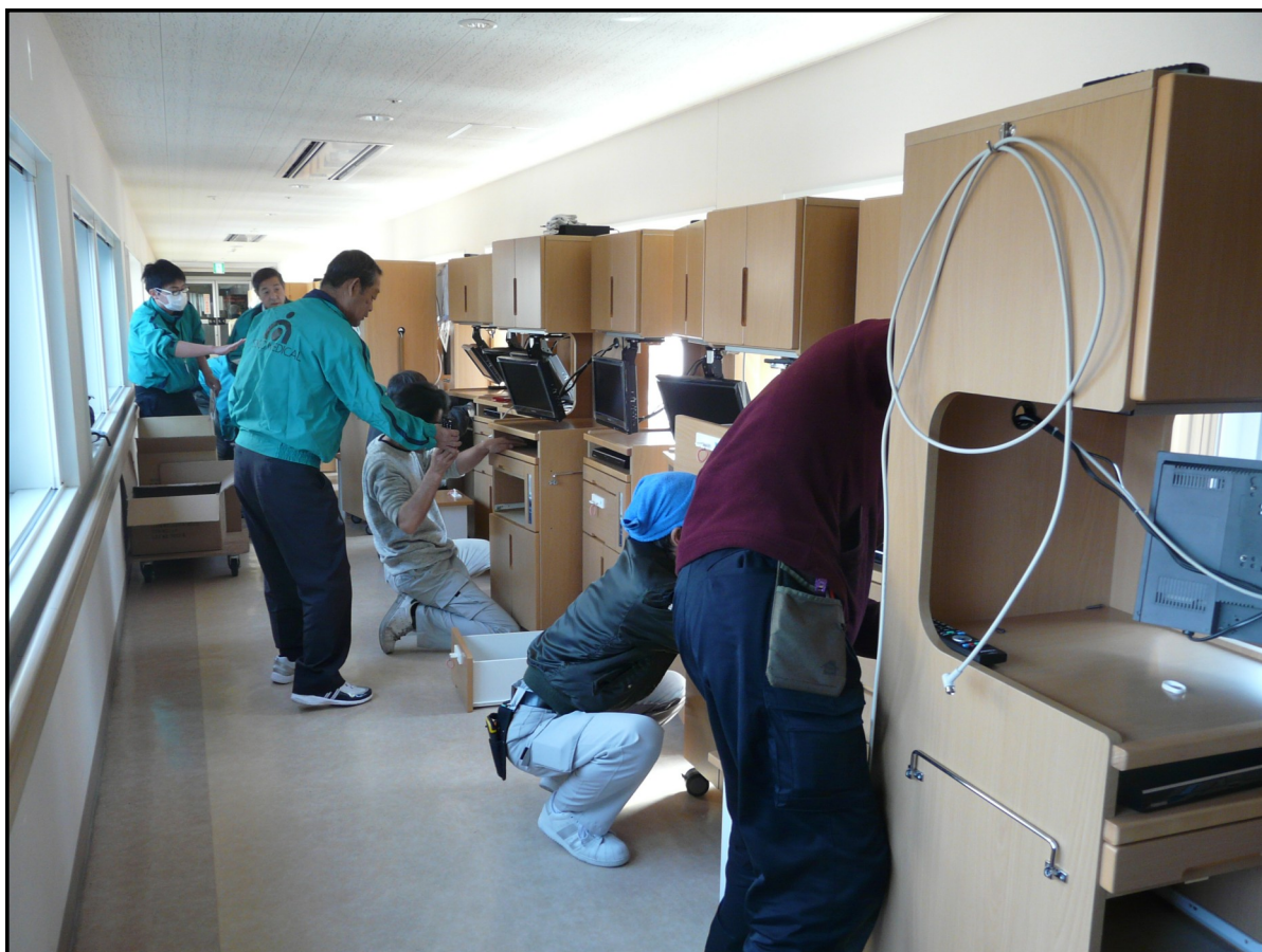
【TV付床頭台の入れ替え作業】
