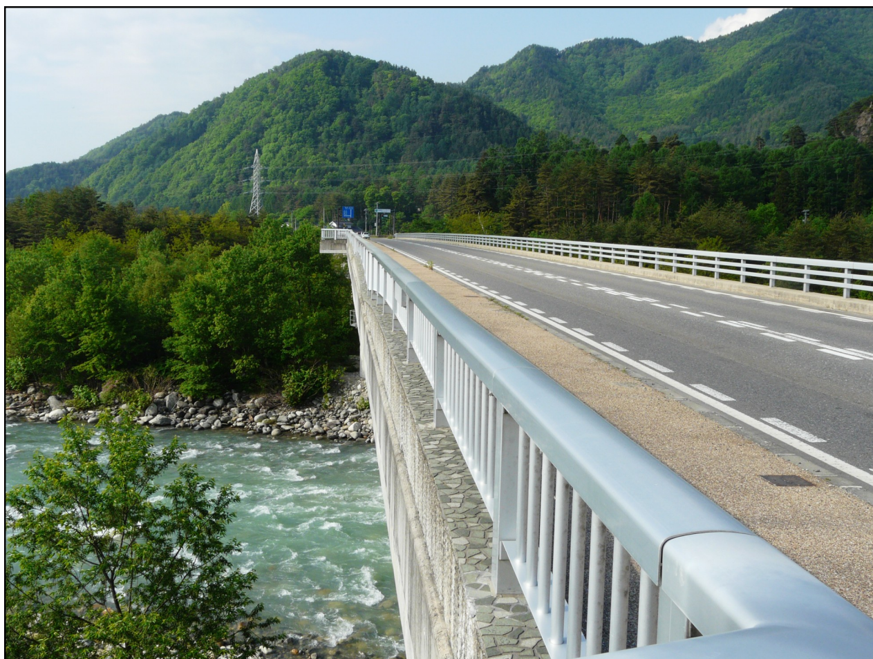
【高瀬川に架かる橋その7：蓮華大橋（大町市平）】
