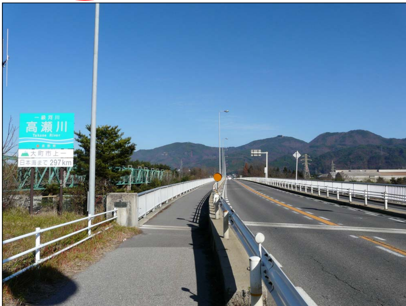
【高瀬川に架かる橋その4：高瀬上橋（大町市）】
